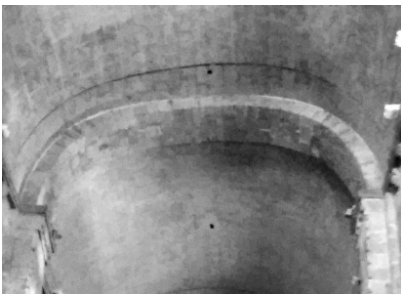
Figura 4. Deformació de l'arc de faixa central (número 3)
